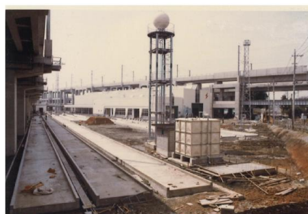
留置線建設風景
