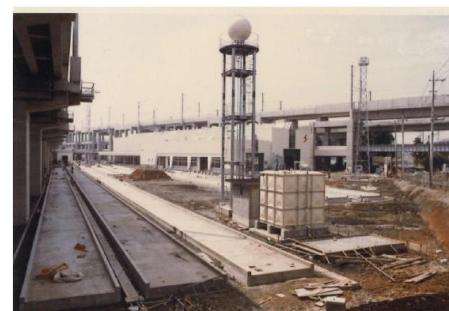
留置線建設風景
