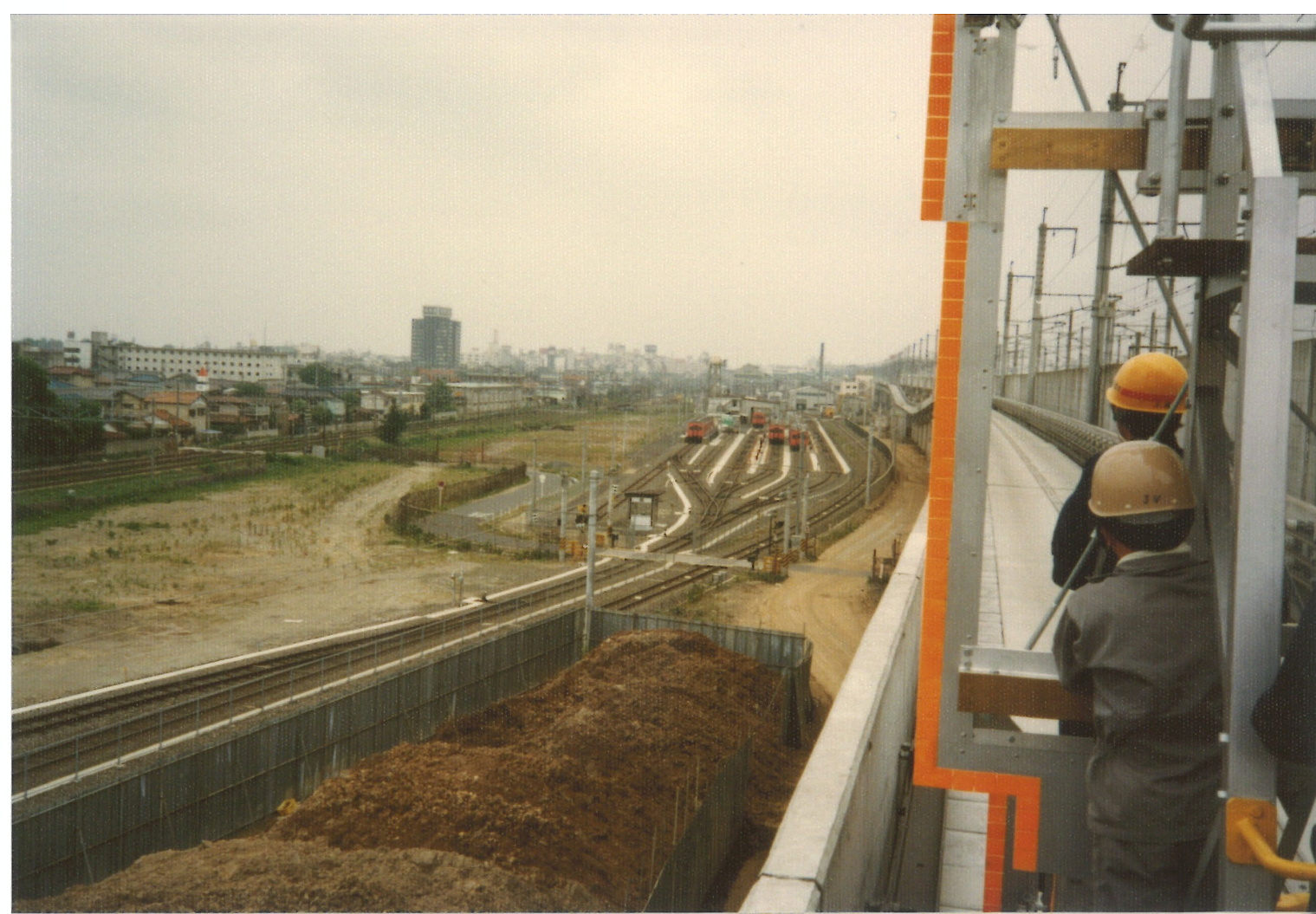
加茂宮～大成駅（現：鉄道博物館駅） 上り線建築限界検査 ※中央付近が現在の鉄道博物館
