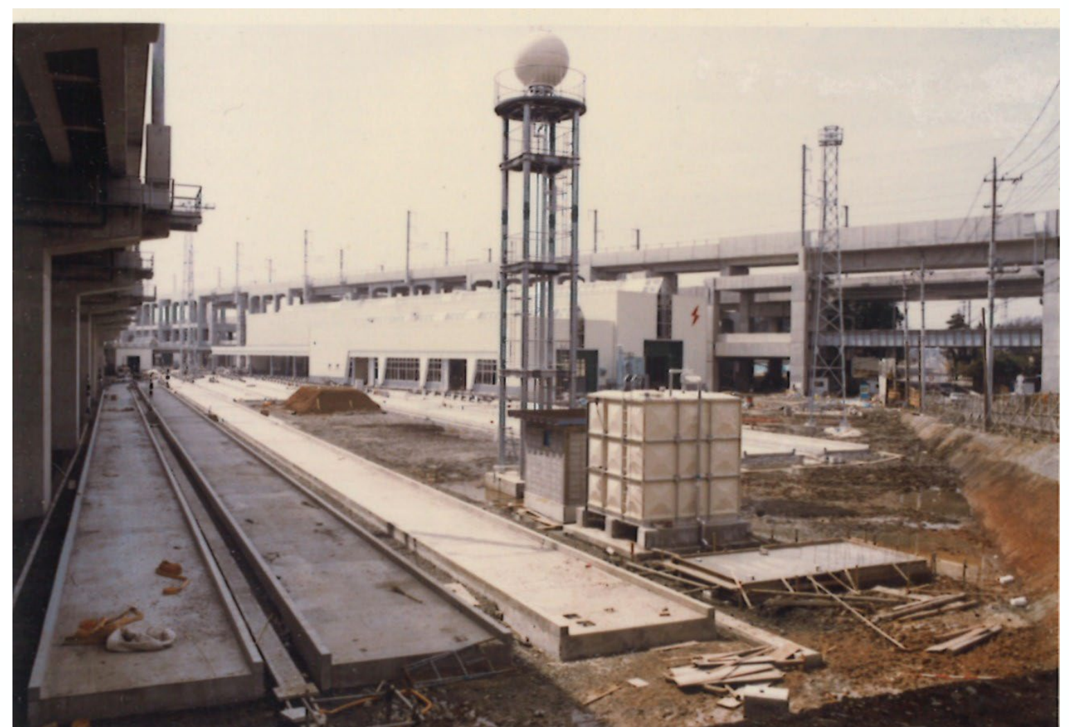
留置線建設風景
