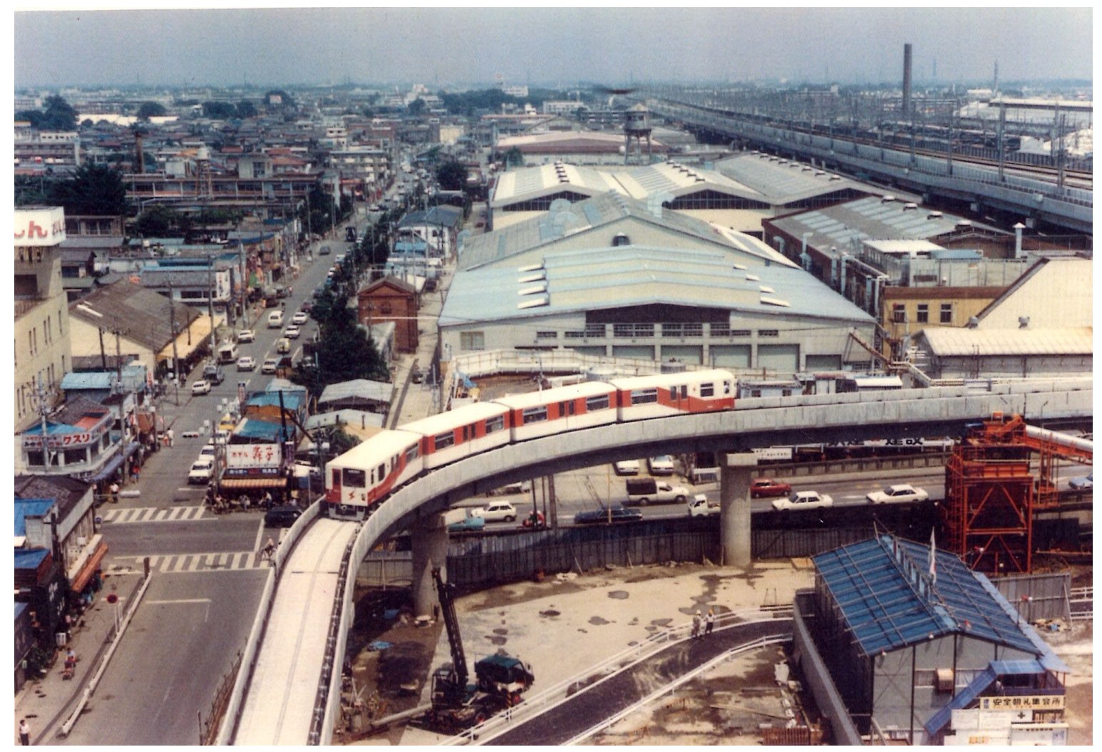
大宮駅を発車してループ線を走行する （JACKビル建設中）
