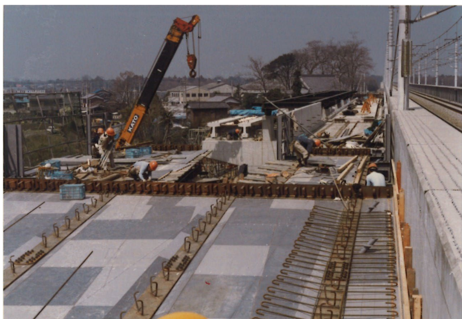
小針駅（仮称・現内宿駅）建設風景
