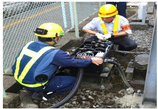
転てつ機取扱訓練
